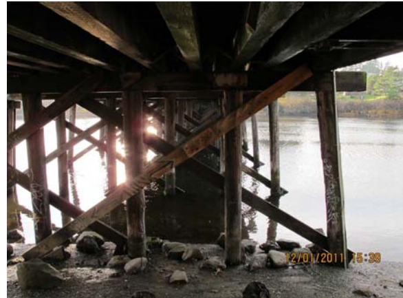
Photo 2-2 Creosote timber pile matrix.
