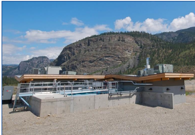
Senkulmen WWTP, BC
