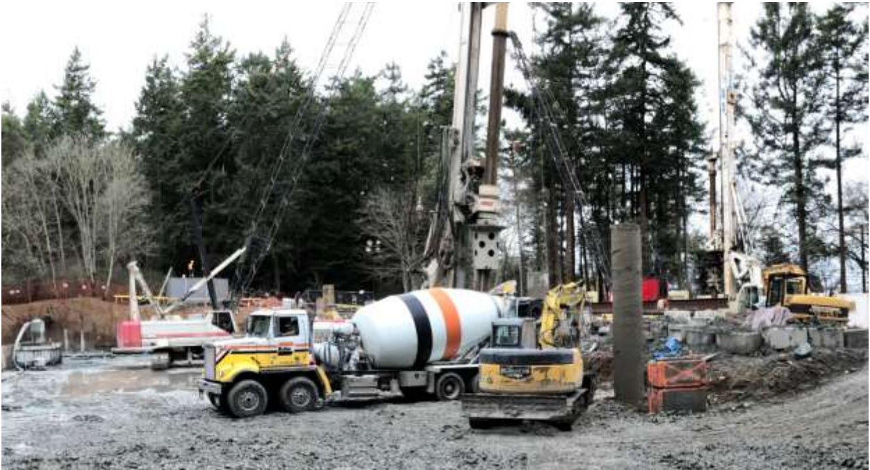
Figure 28—Arbutus Attenuation Tank- Concrete pour for Secant Pile.
