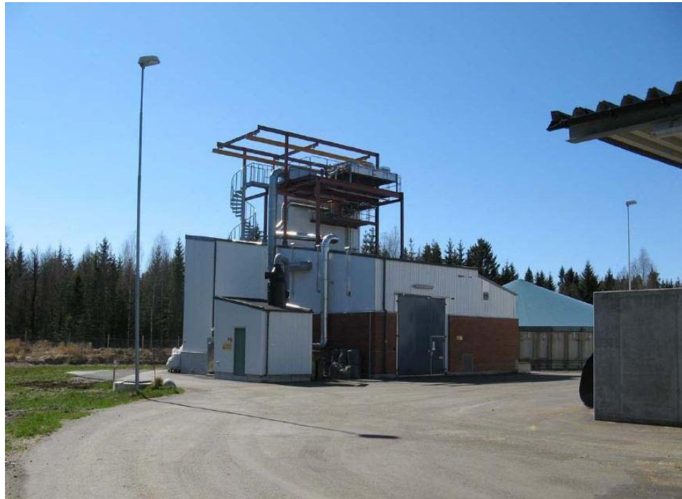
Figure 18 The Västerås Svensk Växtkraft Biogas Upgrading Facility
