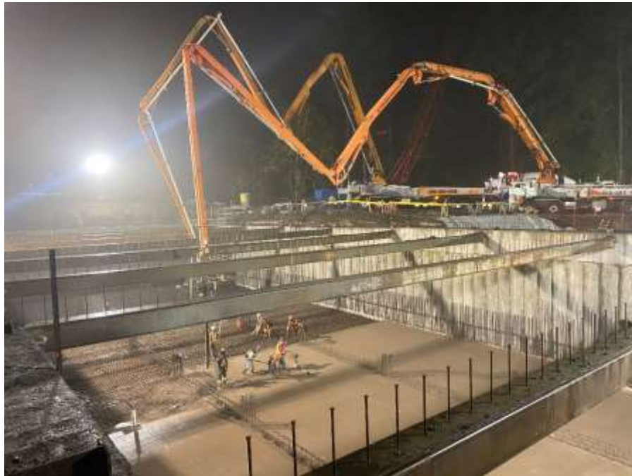
Figure 20–Arbutus Attenuation Tank- Base Slab night time concrete pour
